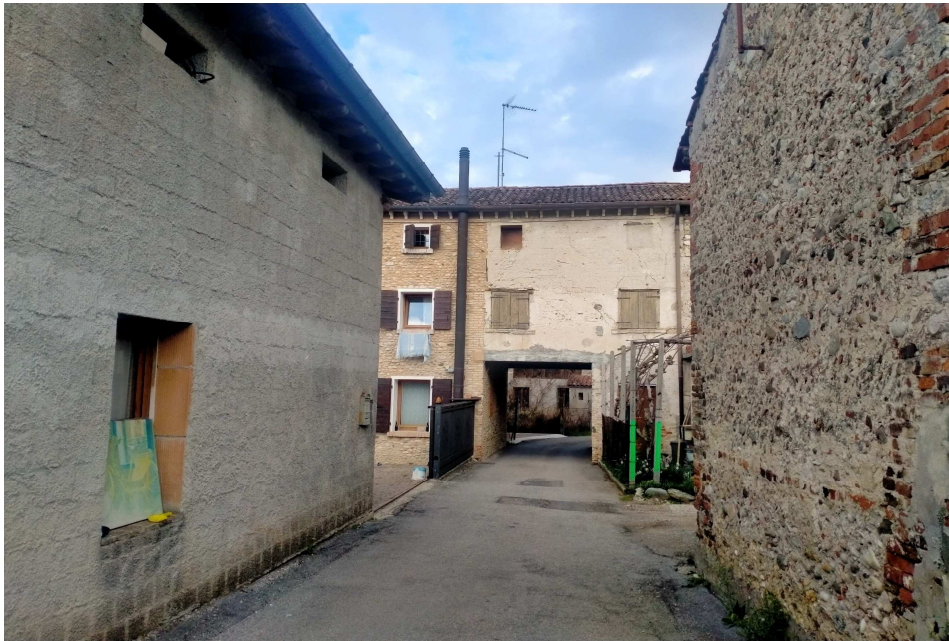
(il caratteristico sottopasso di ingresso)
